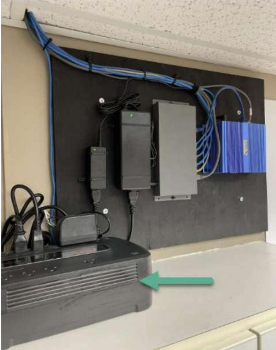
**良い例：ブリッジは合板に取り付けられ、ケーブルはまとめて固定されている。すべてが金具でしっかりと固定された状態。UPS電源ソリューションに注目。**
