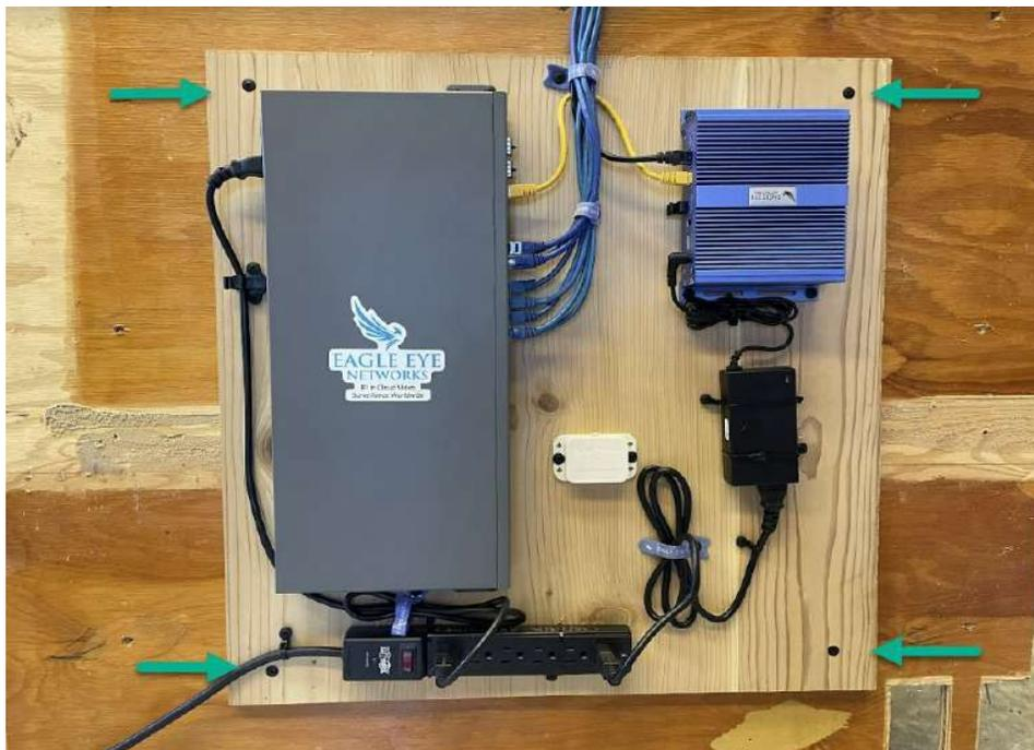
**良い例：少なくとも4本の太いねじをスタッドに直接使用するか、太いアンカーを使用して合板に取り付けています。**
