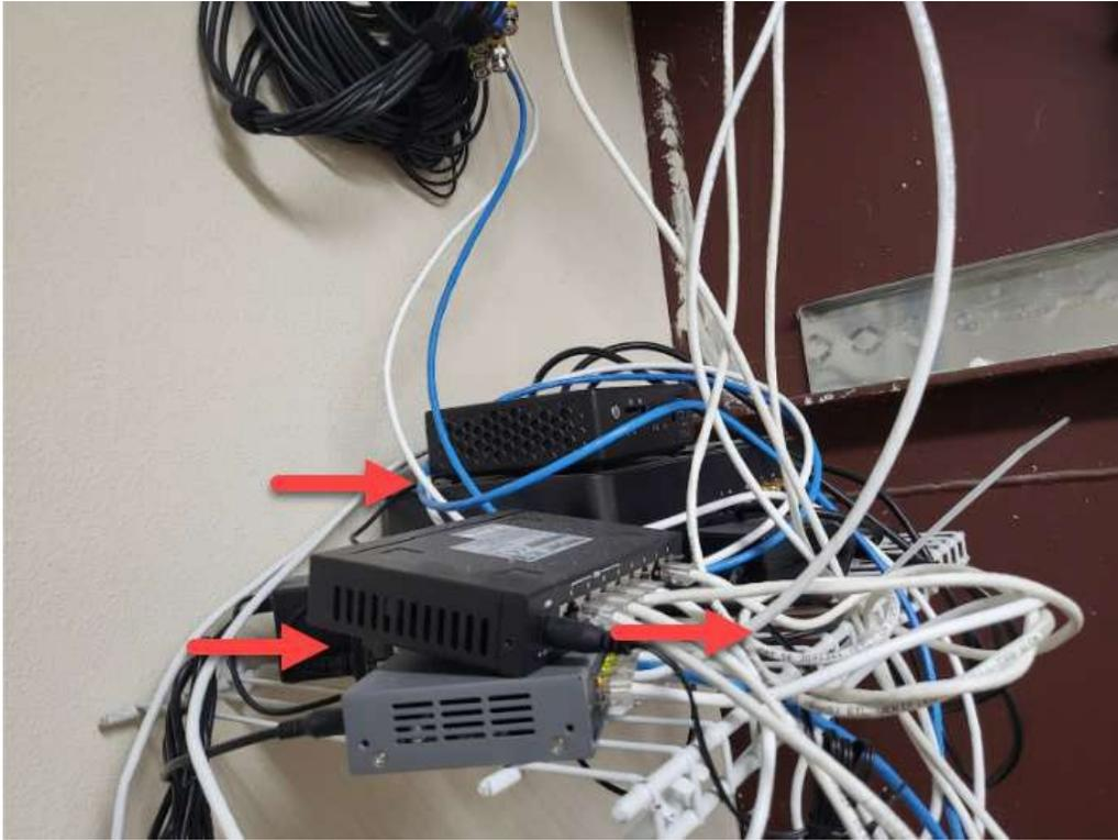
**不良例：電子機器を重ねて置くことより機器の温度が上昇する恐れがあり、固定されずにぶら下がっているコードは外れたり破損の原因となる。**
